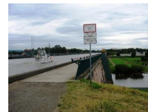
Wasserstraßenkreuz bei Minden. Oben der Mittellandkanal, unten die Weser. Foto: Wilfried Kuhn
